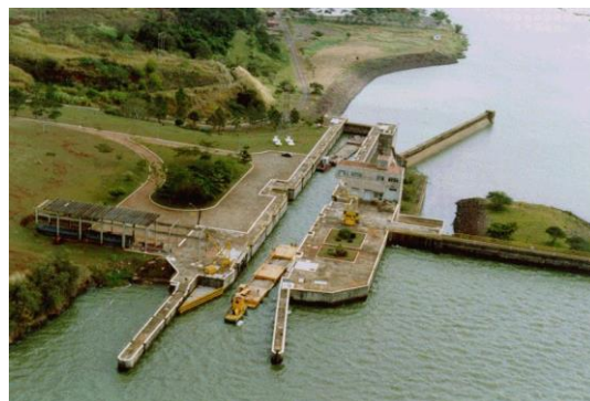
Eclusagem montante para jusante da UHE de Barra Bonita
